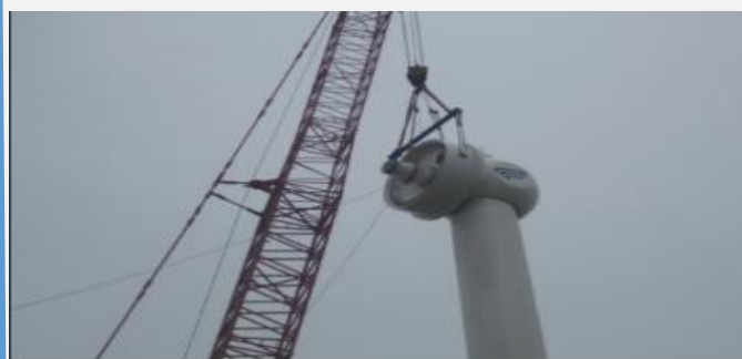
风电项目建设管理
